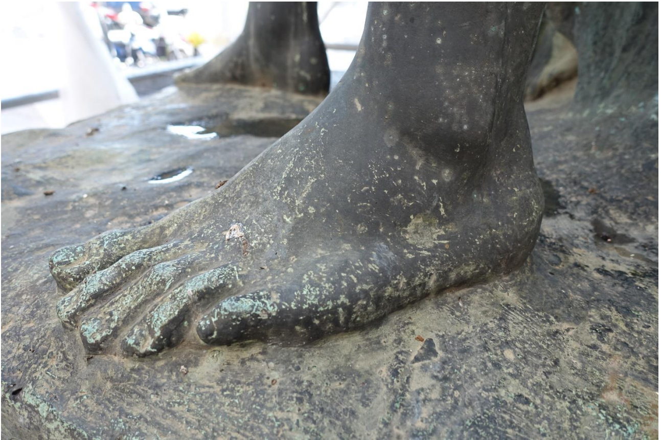
Figura 11 – La base e il piede del Milite: depositi e incrostazioni
