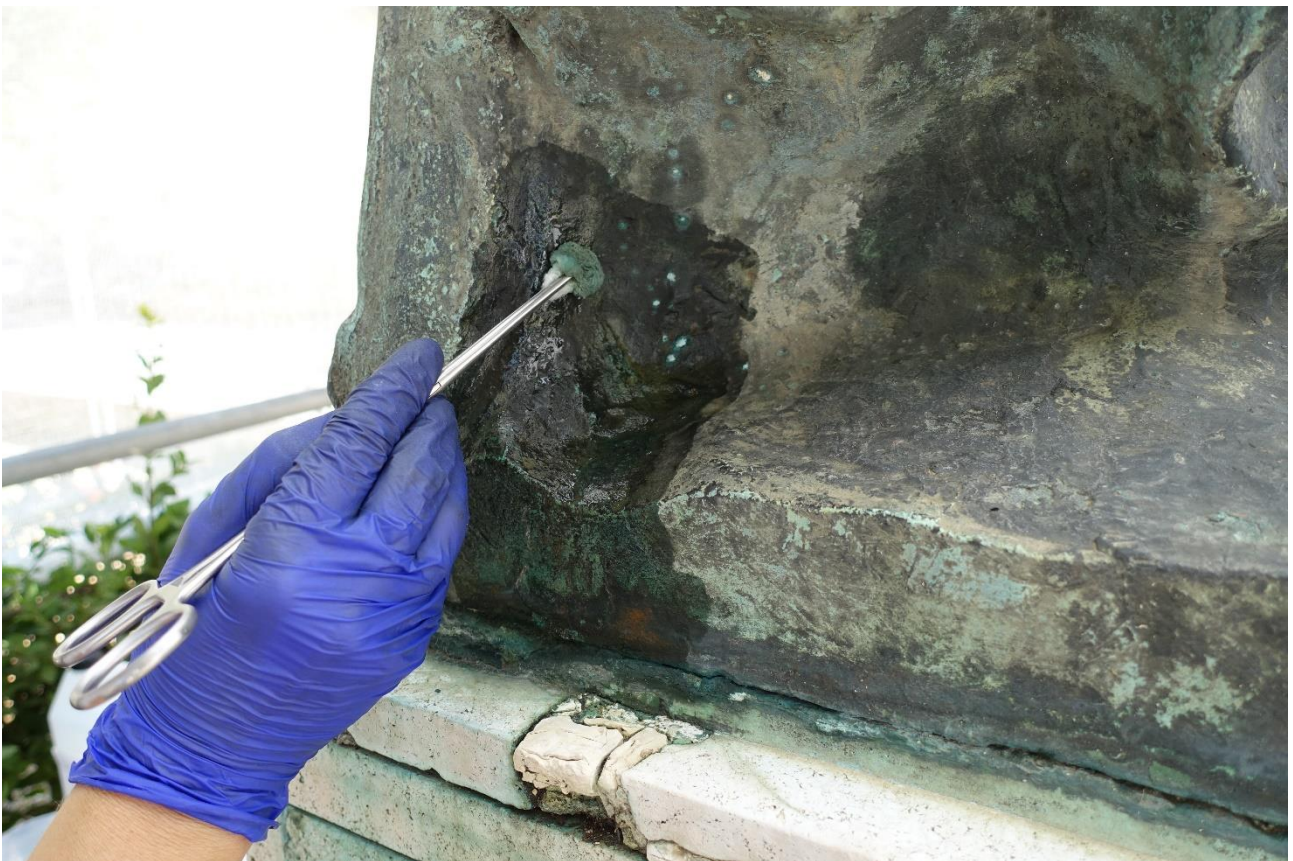
Figura 14 – Esecuzione di un tassello di pulitura chimica
